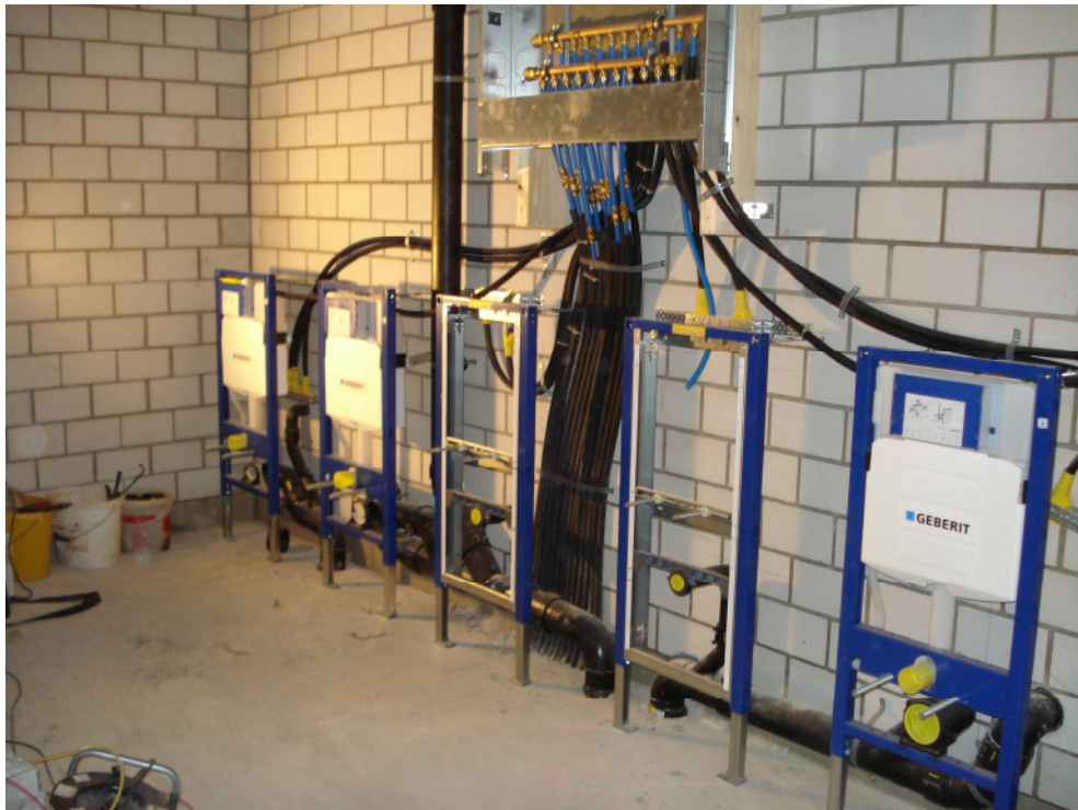
UP-Kasten mit Sanipex angeschlossen
