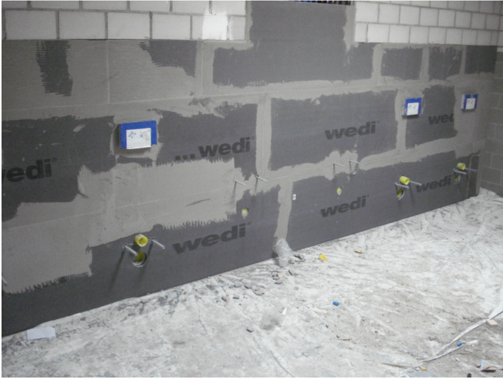
Einmauern der Spülkasten
