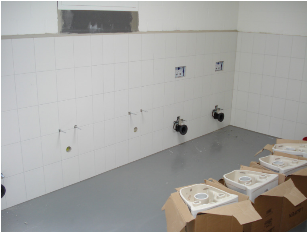
Raum bereitgestellt zur Apparatenmontage
