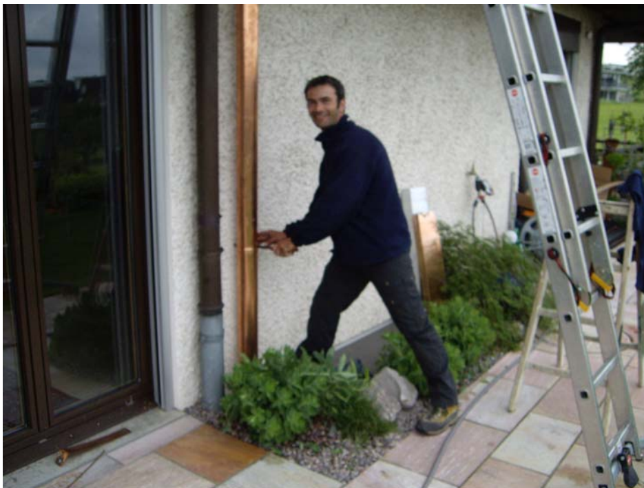
Vorbereitung Solarleitung von Spengler Reto. Geführt in Kupferrohr.
