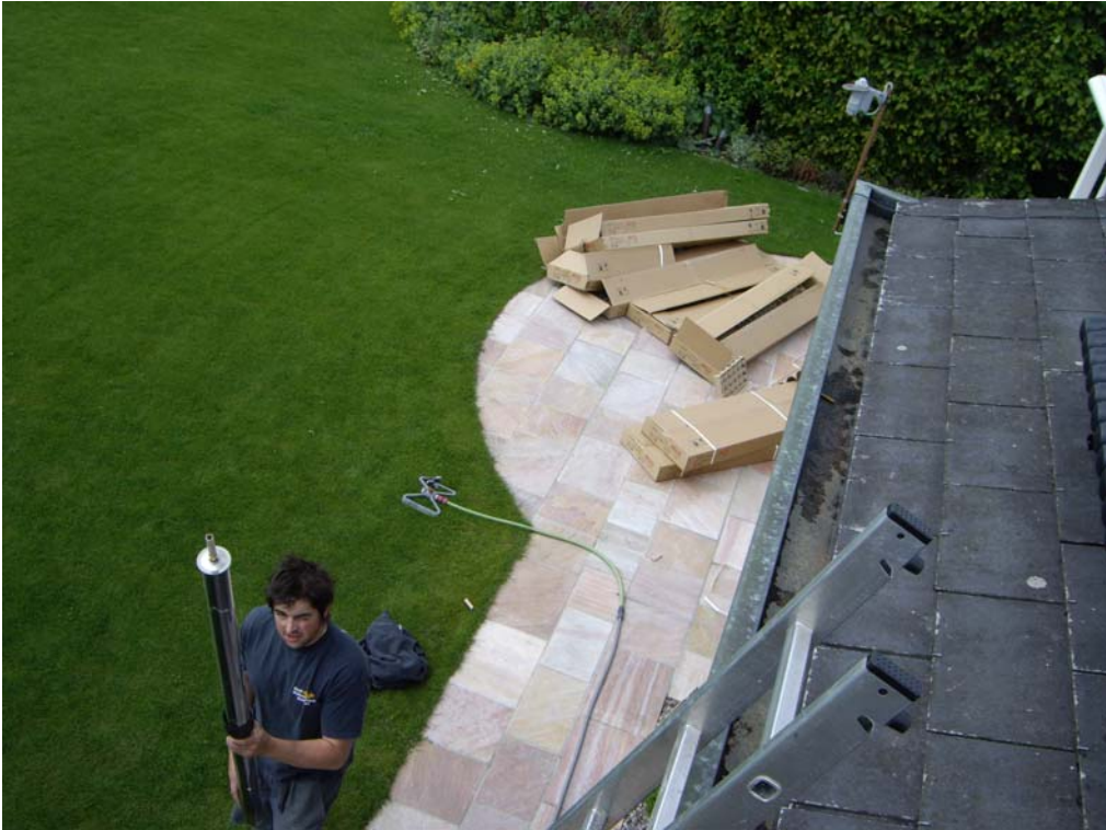
Montieren der Vakuumröhren Yves Gsell
