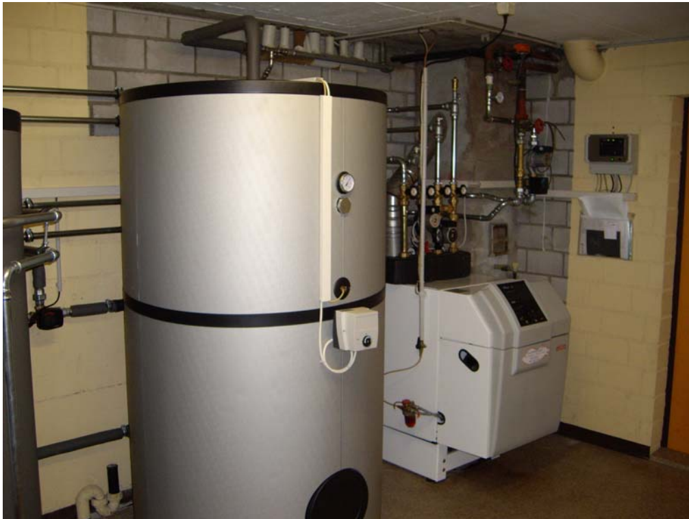
800 Liter Pufferspeicher mit 140 Liter Expansionsgefäß
