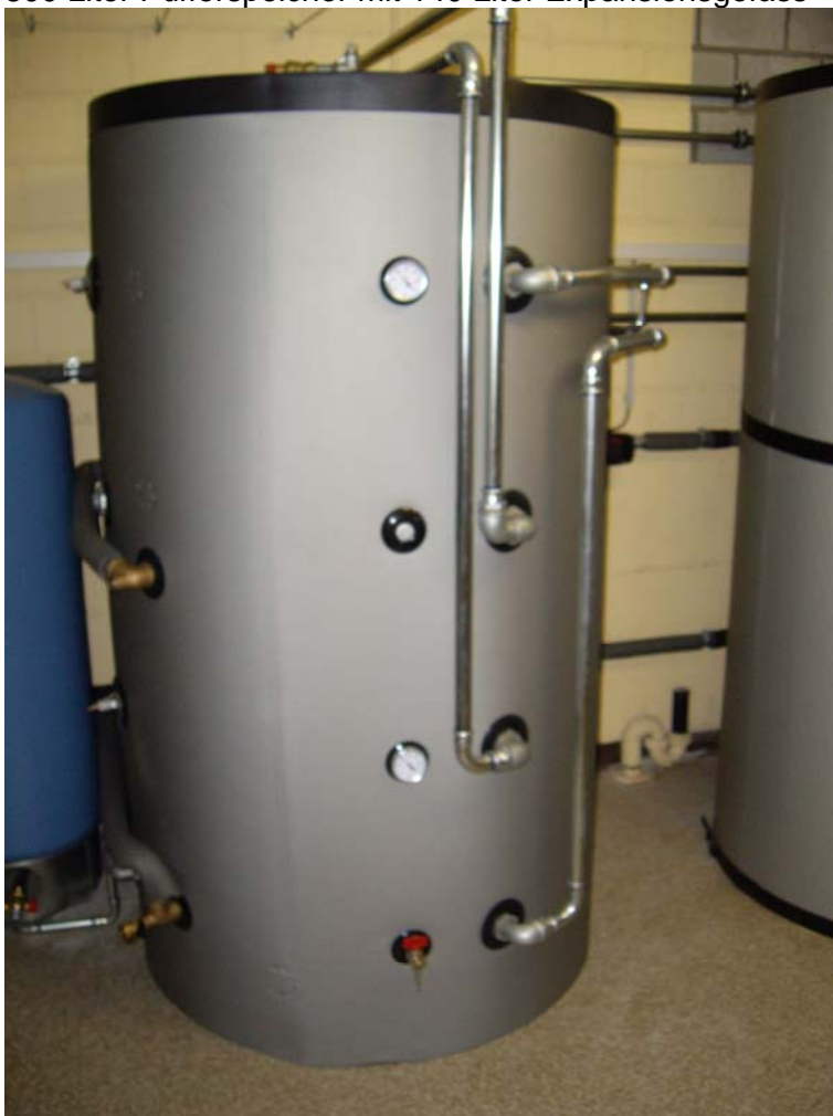
800 Liter Pufferspeicher mit 140 Liter Expansionsgefäß
