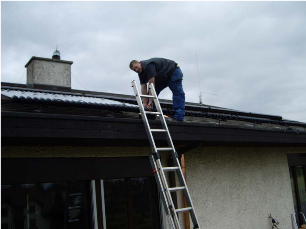
Andi Koller beim montieren der Röhren
