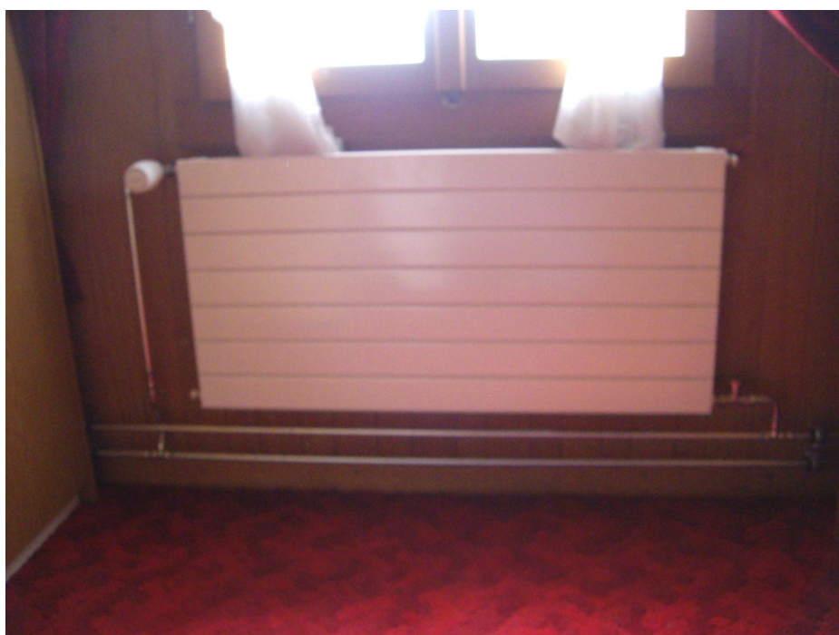
Zehnder Heizwände mit Danfossventilen
