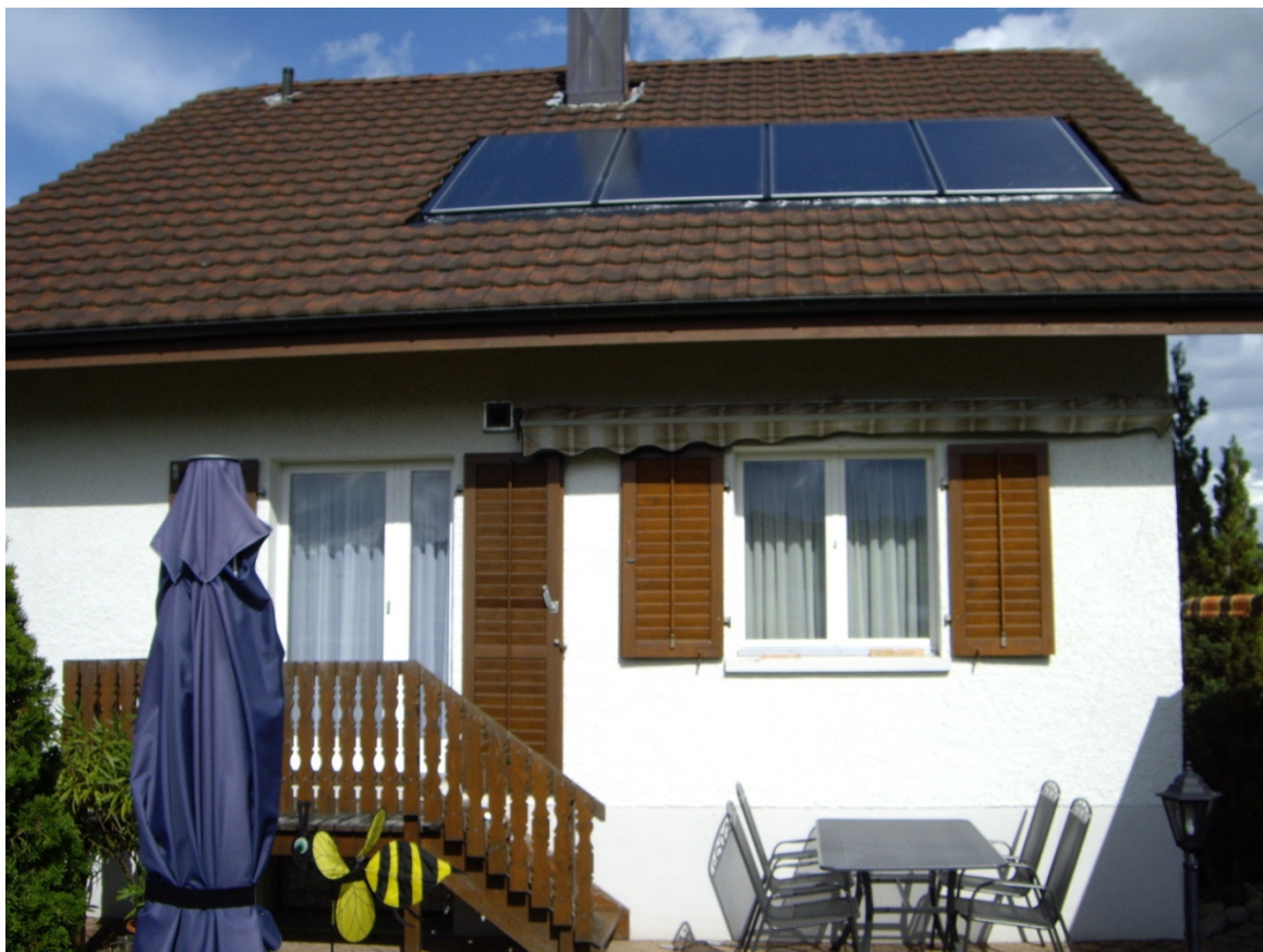
Fertig montierte 8 m 2 Inndach-Solaranlage
