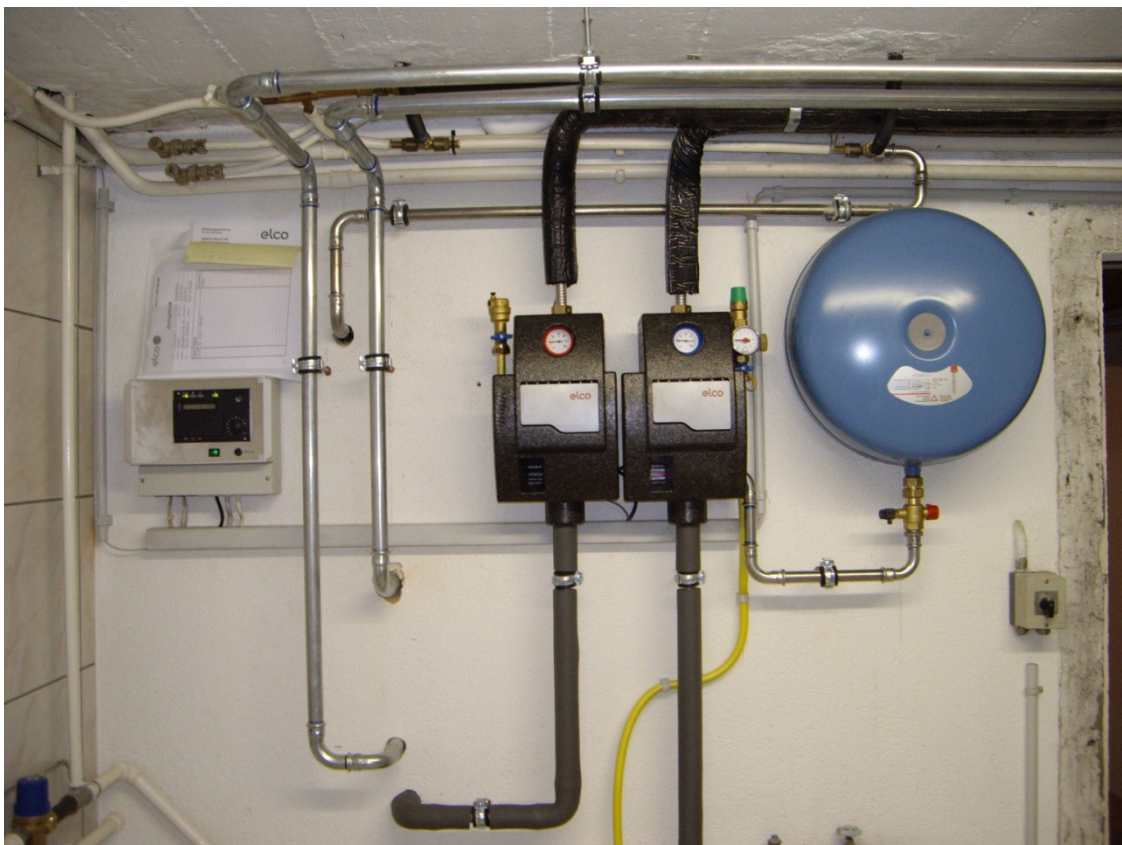
Solarsteuerung mit Solargruppe und 50 Liter Expansionsgefäß
